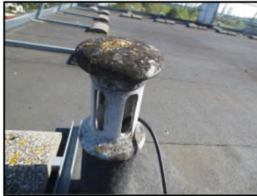
Photo N° 666 AMIANTE CIMENT -- Toiture terrasse Toiture Chapeau (Fibres-ciment)
